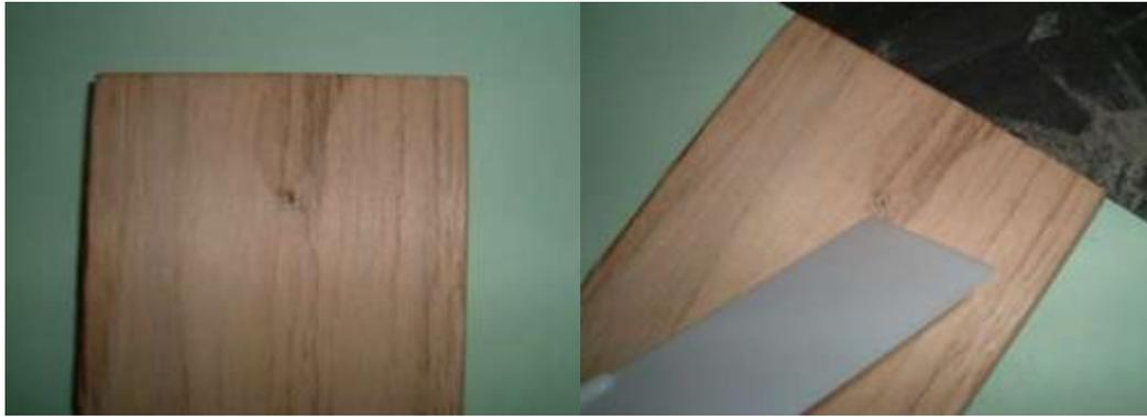
(二) 洞口大一點：先塗膠再用木頭螺帽打進去填補(如下圖所示)，螺帽木頭的材質必須與木頭的材質略相同。
