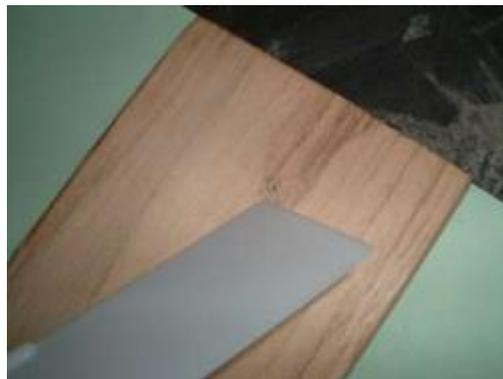
(三) 洞口稍大一點：先在洞口的左右削整呈眼睛形狀，再埋入油灰，注意油灰顏色需調至和木頭顏色接近，等過一天後油灰乾
